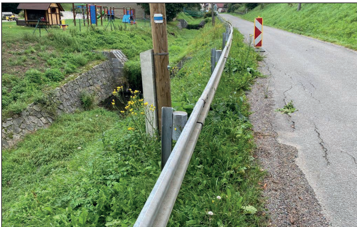
Poškozená vozovka svahovými pohyby
